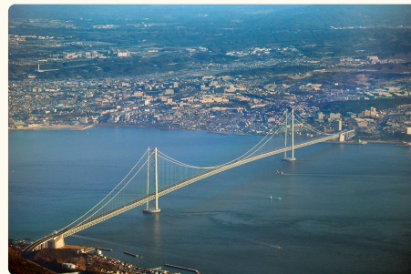
Figura 16 - Ponte Akashi-Kaikyo suspensa e de treliça em Kobe, no Japão.
