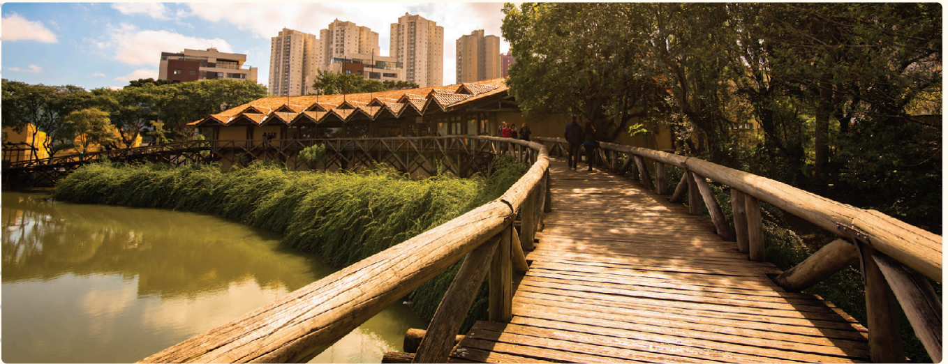
Figura 1 - Ponte de madeira do parque Jardim Botânico de Curitiba - PR.
