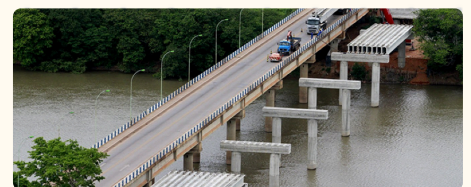
Figura 12 - Exemplo de uma ponte em vigas sendo construída.
