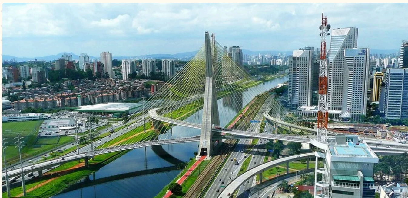
Figura 5 - Ponte Octavio Frias de Oliveira, em São Paulo-SP.
