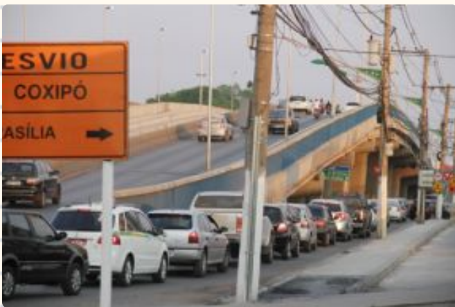
Figura 9 - Viaduto mal planejado em Mato Grosso (MT).
