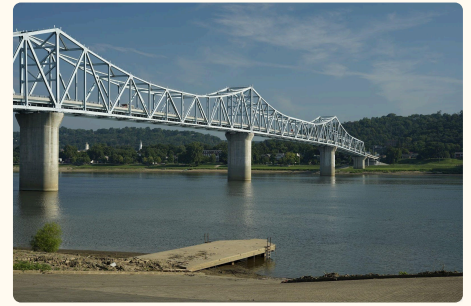
Figura 13 - Ponte feita inteiramente de treliças.
