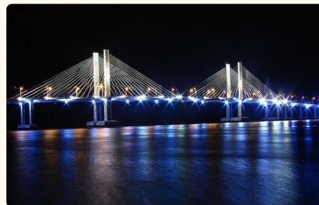
Figura 17 - Ponte Aracaju-Barra dos Coqueiros em Sergipe.
